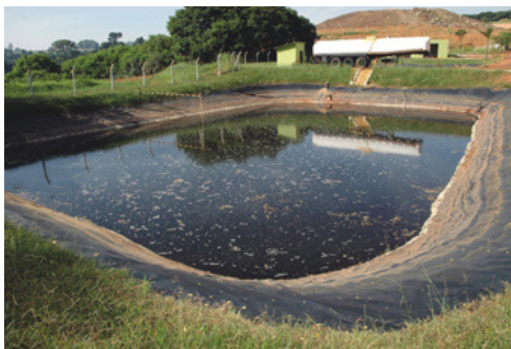
Figura 6 – Local destinado ao tratamento do chorume Fonte: < www.terraambiental.com.br >
